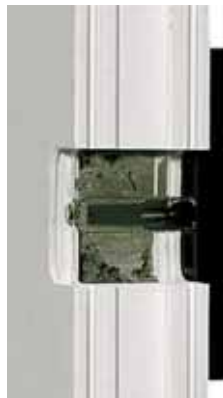
Scellement chimique pour châssis PVC dépourvus d'armatures métalliques
